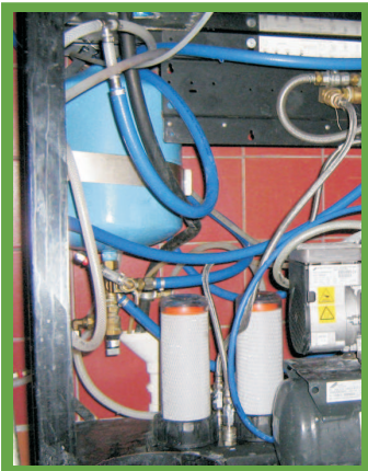
Einbaubeispiel DW-Terra 2 innerhalb des Rahmengerüsts der Schankanlage
