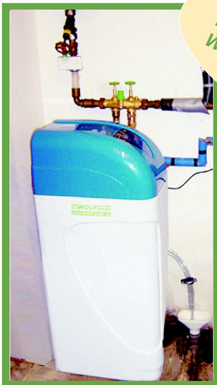
Beispiel für den Einsatz einer Anlage zur Nitratreifernung
