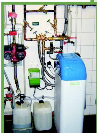
Beispiel einer Kompaktenthärtungsanlage mit Zentralsteuerventil Clack
